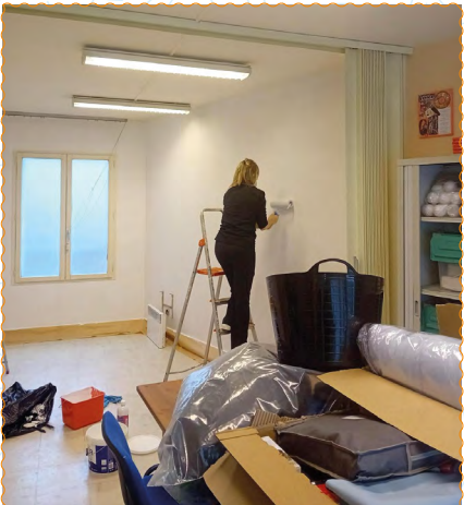
♦ Travaux de rénovation, Étampes
